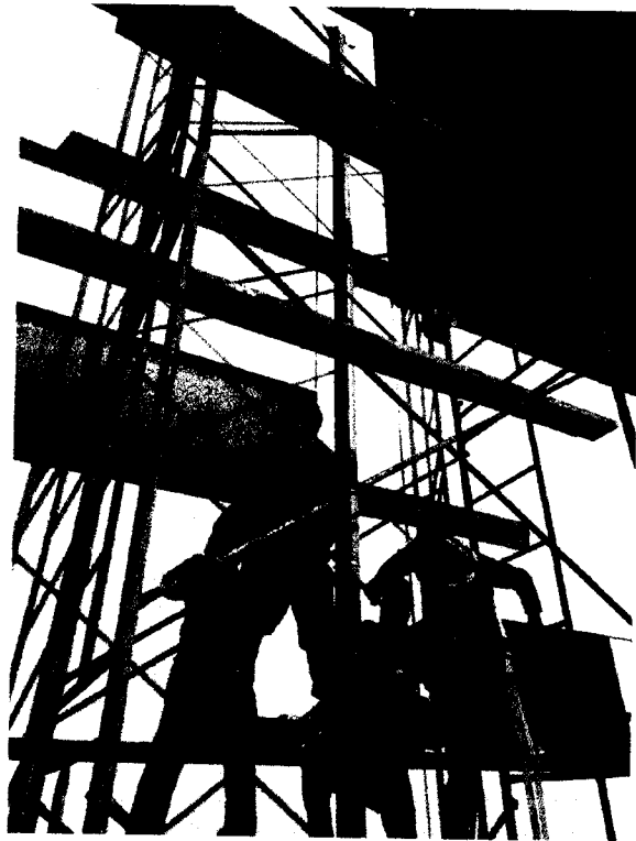
FOTO N° 06: Instalación de montantes pluviales en edificios.
