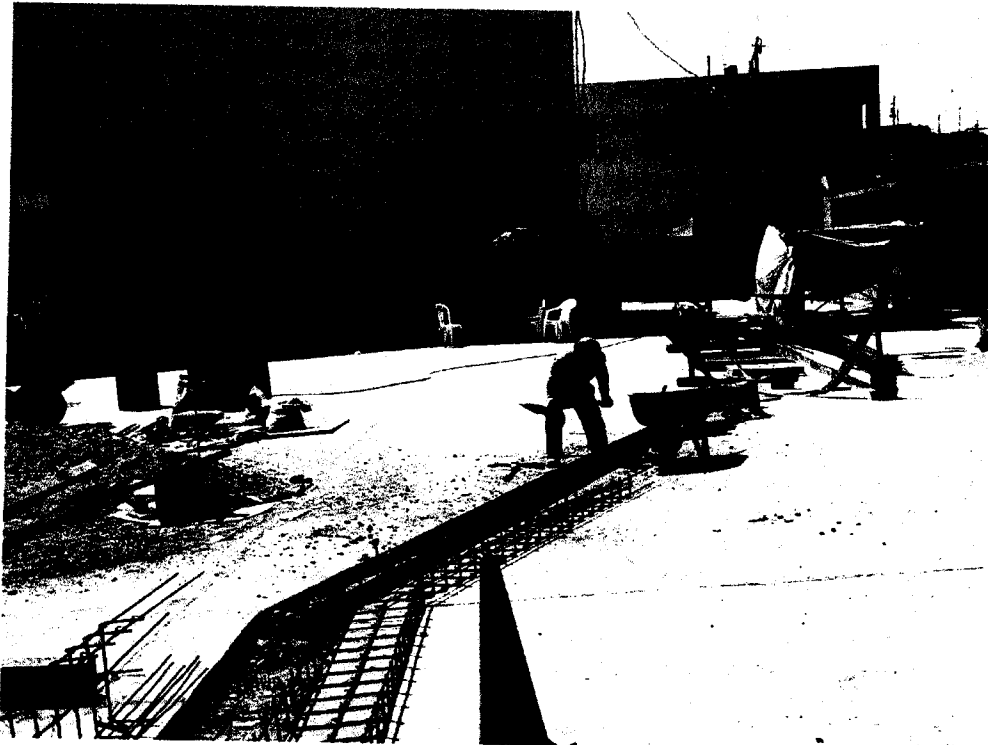
FOTO N° 04: Canaletas de recolección de aguas pluviales en pavimentos rígidos.
